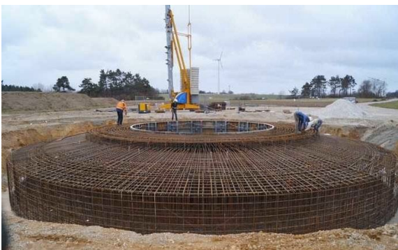
Zuerst müsste das Baugesuch genehmigt werden, um solche Fundamente auf dem Grenchenberg zu giessen. Das Trinkwasser wäre gefährdet.
